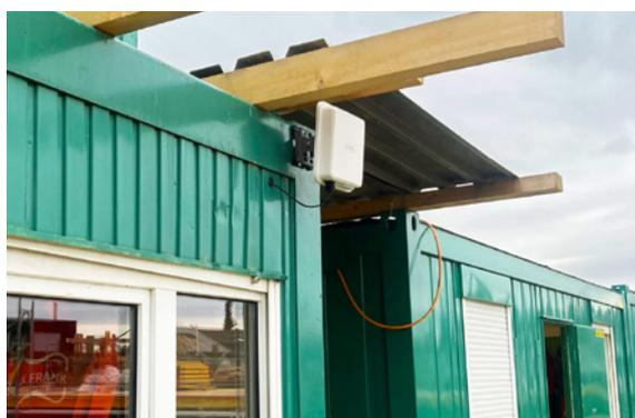
Wand- und Mastmontage. Dank der integrierten PoE-Unterstützung (Power-over-Ethernet) ist selbst die Stromversorgung kein Problem mehr.
