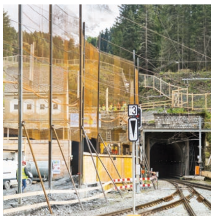
Der neue Tunnel entsteht.
